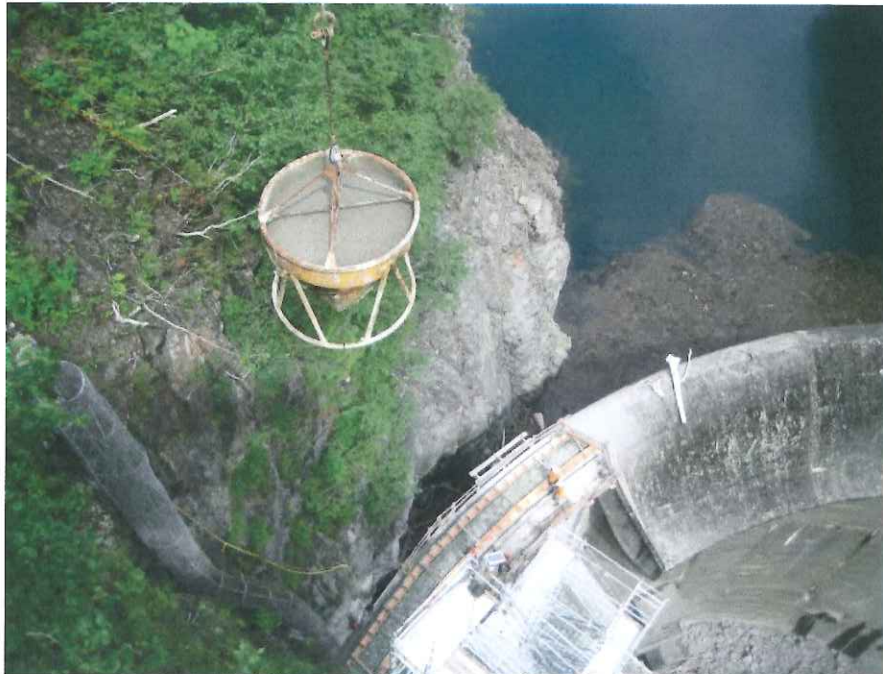
Figure 5: Keyway Concrete Pour
