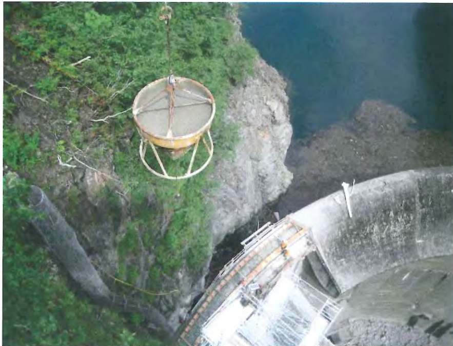
Figure 5: Keyway Concrete Pour
